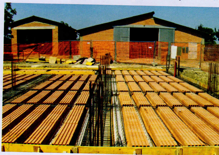
Figura 6 Posa di travetti e pignatte prima della fase finale di getto del CLS.
