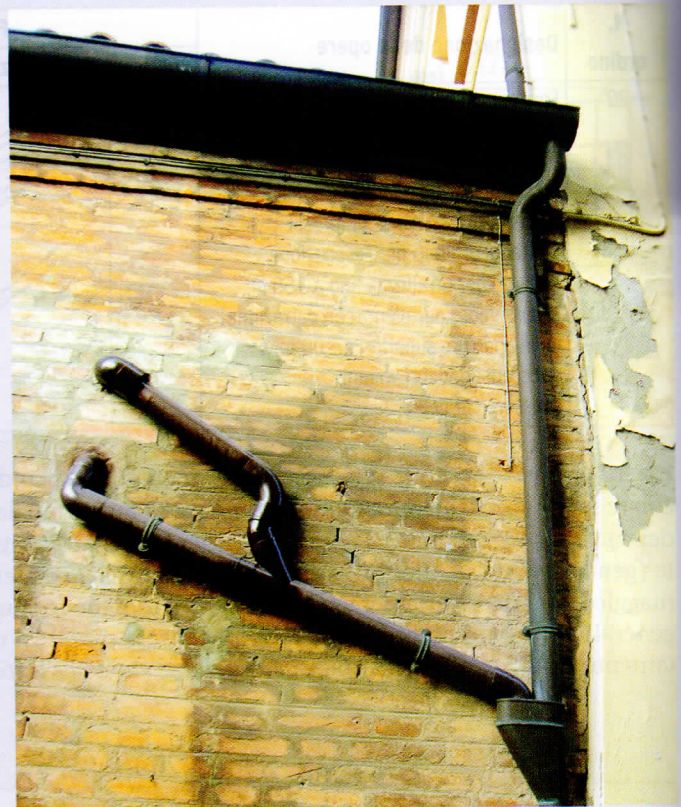
Figura 13 Gronde e pluviali.
